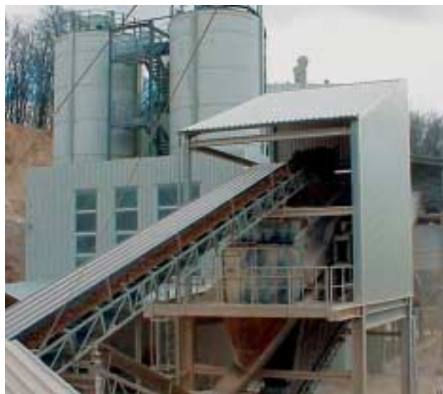
Bild 2: Blick auf den Siebturm, im Hintergrund die Silos für die Rohfeldspatlagerung
